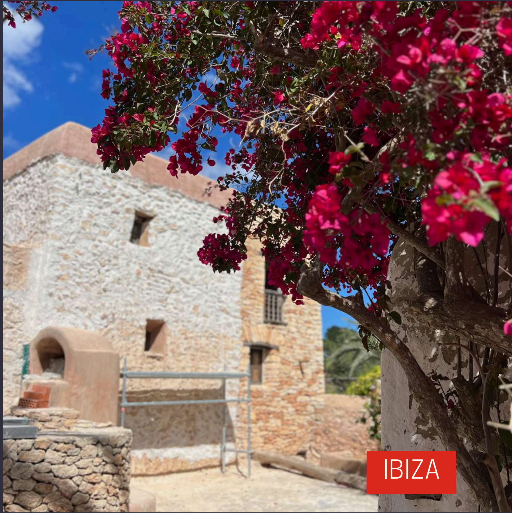
Rehabilitación histórica Masía S. XVI.
